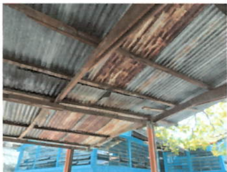
Foto 1: Sustrucción de cubierta de techo con lámina galvanizada, Tipo de lamina: troquelada Calibre: 26, incluye: fijaciones y sellado en traslapes.
