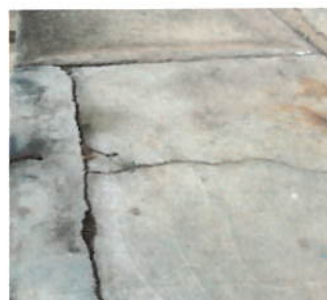
Foto 6: Reparación de losa de concreto paa patios, considerando preparación de terreno, armado. Nivelación y acabado rustico.
