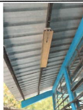
Foto 4: Sustrucción de sistemas de iluminación: Lamparas, por lámparas tipo led.
