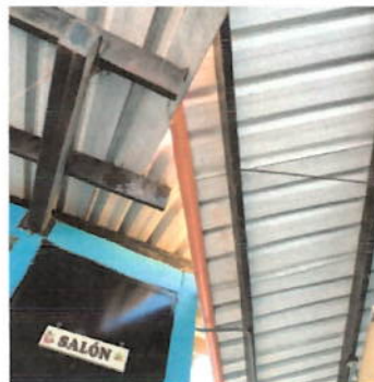
Foto 2: Sustrucción de canales para evacuación de aguas pluviales Material: lamina galvanizada Tipo: lisa, Anclaje: canal sostenido por pescantes metalicos
