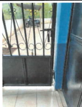
Foto 3: Mantenimiento a portón de ingreso, material: metálico, incluye: bisagras y sistemas de cierre.
