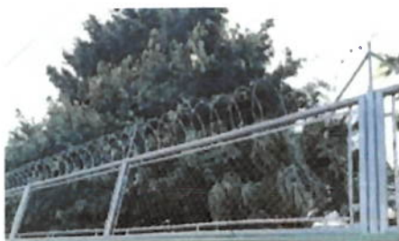
Foto 5: Sustrucción de alambre razor galvanizado.
